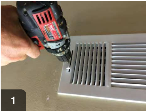
Remove diffuser
